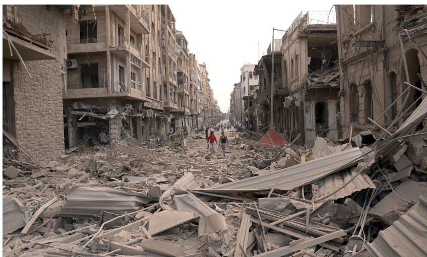
Rue détruite par la guerre à Alep, le 3 octobre 2012
