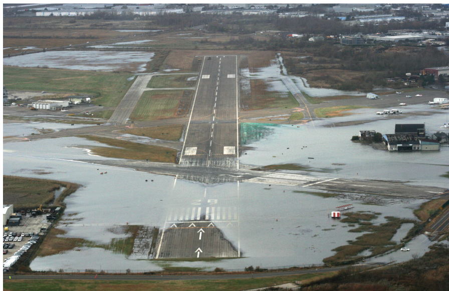
En 2012, l'ouragan Sandy a endommagé des infrastructures critiques sur la côte est des États-Unis. L'OTAN a récemment mis un accent sur le renforcement de la résilience. Garde Nationale du Connecticut
